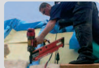
Pour une fixation pneumatique à haute pression jusqu'à 20 bars . Toit. Encadrement de plancher, mur...
